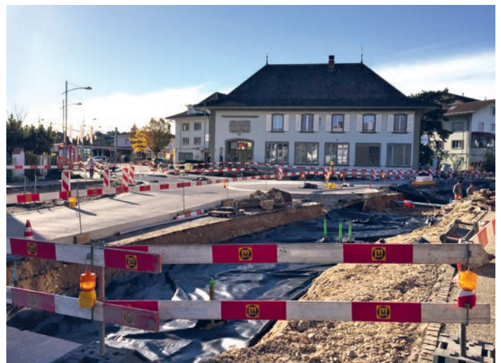
... und der neue Kreisel im Bau.
