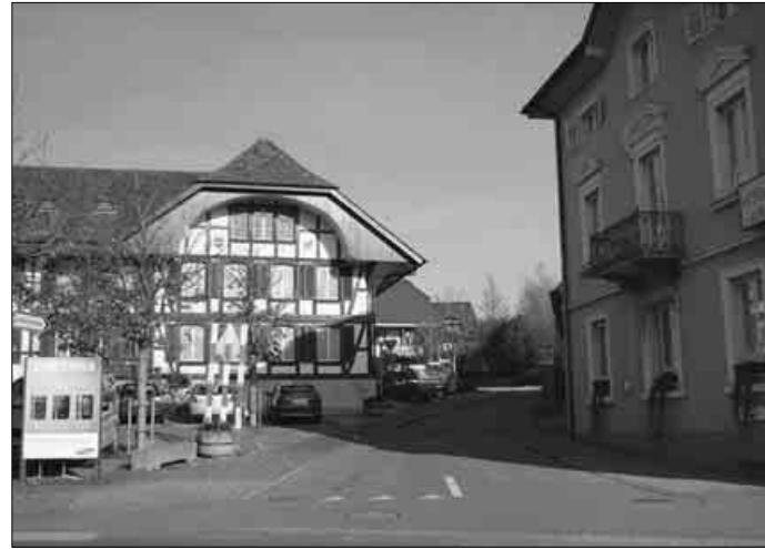
Die Abzweigung Hauptstrasse - Mettgasse: Das Hotel Jura wurde 1875 mit der ersten Strassenbrücke über den neuen Nidau - Bürenkanal erstellt. Das Gemeindehaus wurde 1830 als Schulhaus gebaut.
