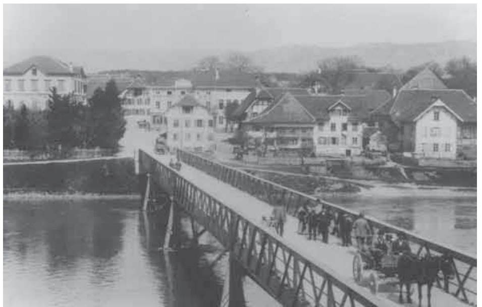
Die Stahlbrücke aus dem Jahre 1868 ca. in den 20-er Jahren des letzten Jahrhunderts.
