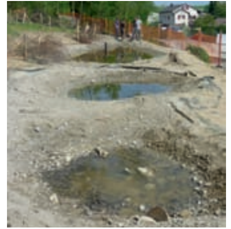
Blick gegen Osten über die ganze Anlage.
