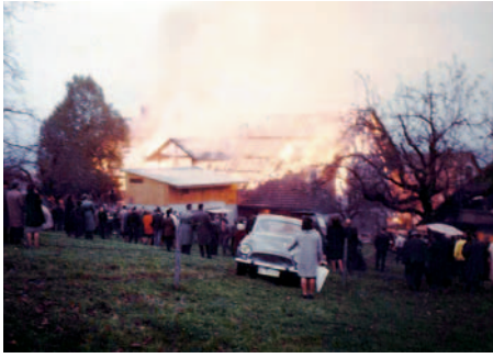
Am 10. November 1963 brannte das Bauernhaus an der Orpundstrasse lichterloh.
