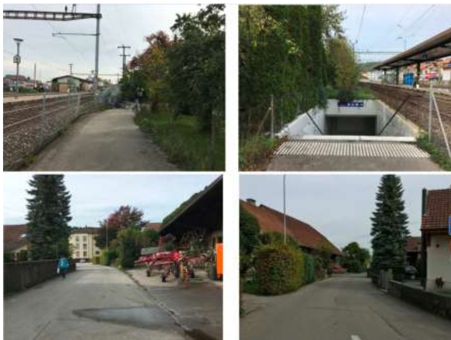
Die südseitige Anbindung an den Bahnhof ist schlecht wahrnehmbar und entspricht nicht den aktuellen Anforderungen.
