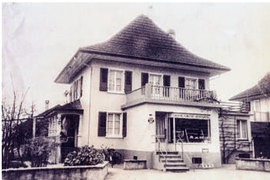
Die Bäckerei Baumgartner an der Bielstrasse. Anschrift: «Bäckerei, Konditorei, Kolonialwaren».
