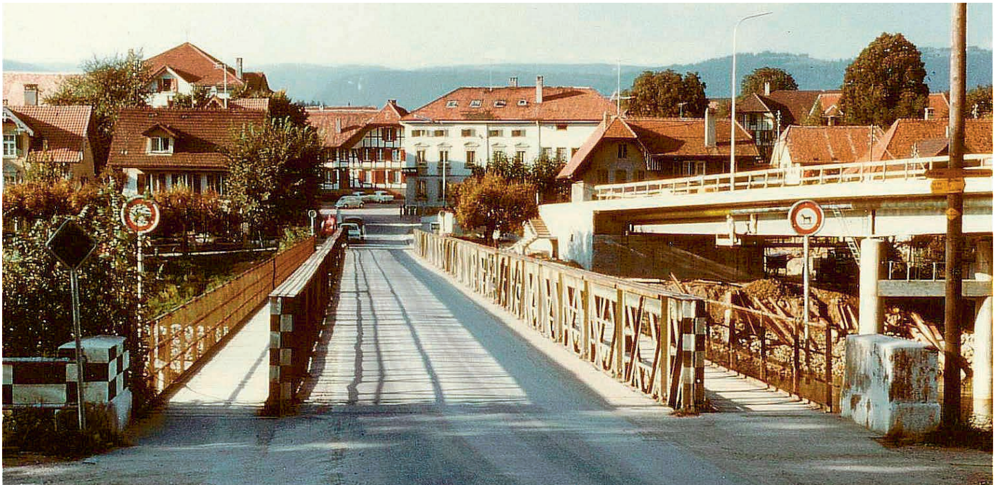
Die neue Aegertenbrücke ist im Bau, die alte Eisenbrücke wird noch benutzt, ca. 1970 ...
