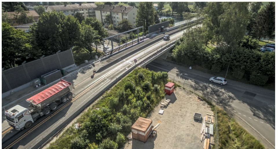
Sanierte Unterführung Neubrückstrasse
