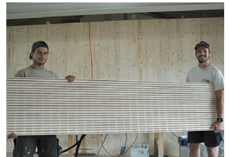
Holzbau: Die Zimmermänner Lukas Müller und Jan Jaberg (Felma Holzbau, Lyss) halten auf der Baustelle die Distanzregel optimal ein. Die beiden montieren das Akustiktäfer.
