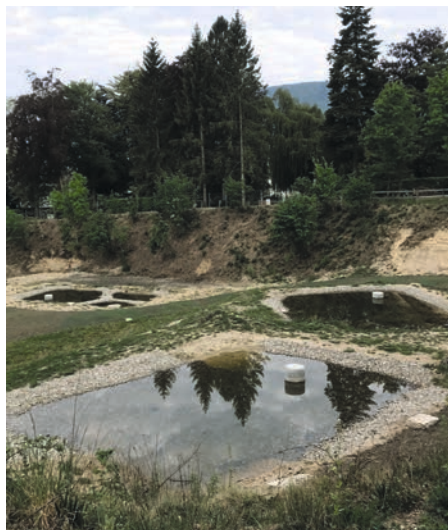
Am Südportal des Längholztunnels, das kürzlich fertig erstellte Biotop
