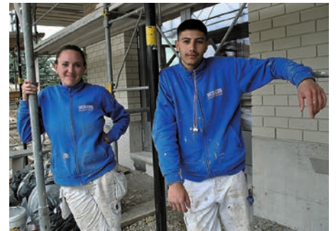
Malerarbeiten: Malerin Andrea Egger und der Lernende Daniel Zekic (Schori Malerei, Brugg) sind fast fertig mit den Aussenarbeiten. «Doch drinnen hat es noch einiges zu tun», so Egger.
