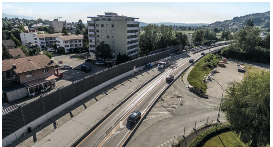
Lärmschutzwände nach Expokreisel (Blickrichtung Lyss)
