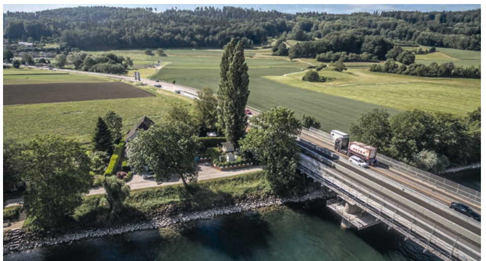
Sanierung Brücke Nidau-Büren-Kanal (Blickrichtung Lyss)
