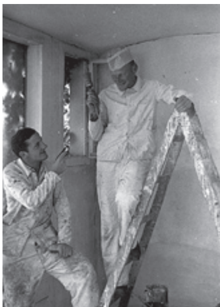
Hans Schori beim Renovieren eines Zimmers, zusammen mit einem deutschen Gesellen.
