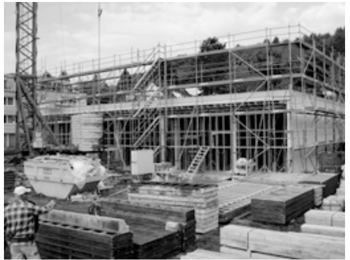
Südansicht des Rohbaus der Basisstufe und Aula auf dem Bärletareal. Bild vom 26. Oktober 2009.
