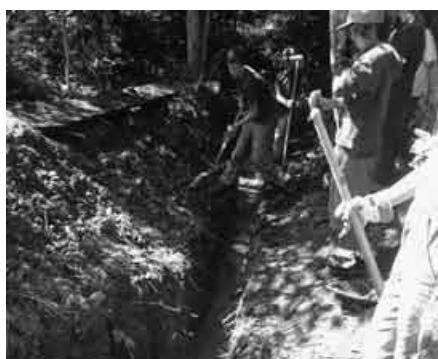
Einen Entwässerungsgraben bauen.
