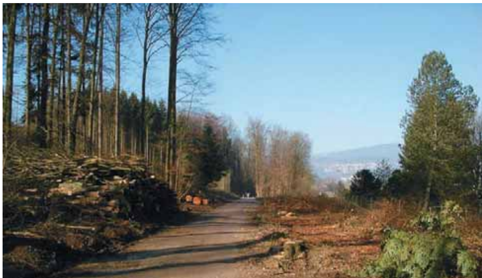
Der jetzt bestehende Spazier- und Forstweg wird für den Bau nach Süden verlegt.
