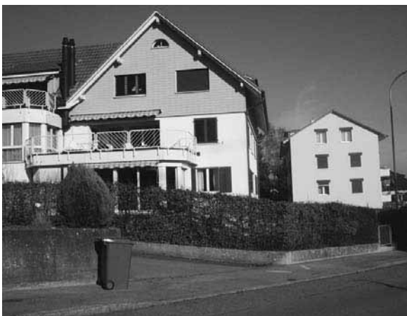
Schmucke Mehrfamilienhäuser auf der Nordseite der Rainstrasse
