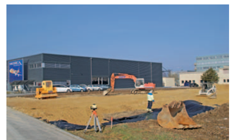
Die Bauarbeiten haben begonnen.
