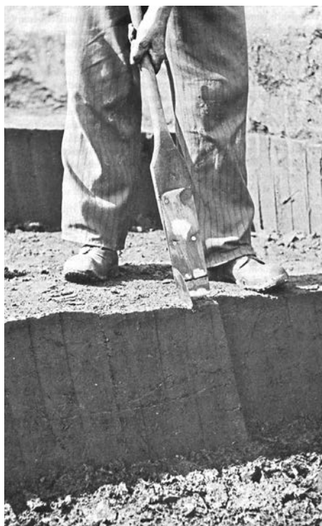
Arbeit mit einem Torfstecher. Der Vorstecher hat bereits die Grösse der Ziegel vorgegeben, das Stecheisen sticht im richtigen Format.
