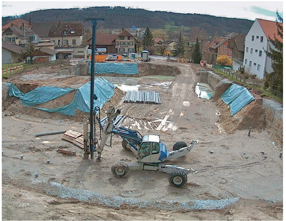
Setzen der langen Pfähle im Baugrund zwecks Stabilitätserhöhung
