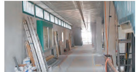
Renovationsarbeiten, hier im Korridor Erdgeschoss
