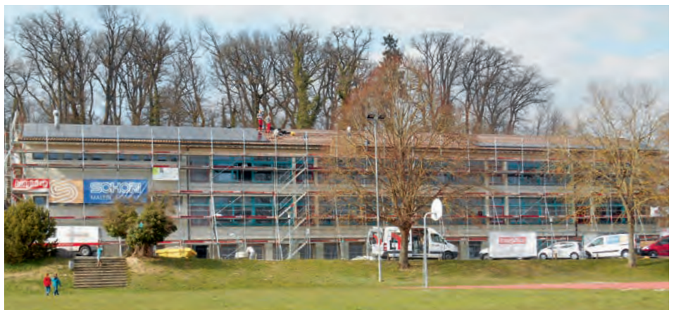
Im April dieses Jahres wird die Fotovoltaik-Anlage montiert
