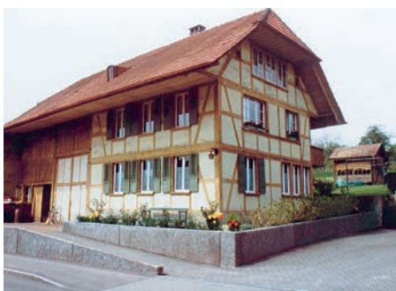
Das Haus von Getruds Grosseltern: Die Fenster in den oberen Stockwerken deuten noch auf ein Uhrenatelier hin.
